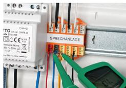
Die Prüfung erfolgt in der Prüfoffnung auf
