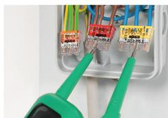
Die Prüfung erfolgt in der Prüfföffnung auf der den Leitereinführungen entgegengesetzten Klemmenseite.
